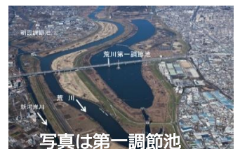
写真は第一調節池
