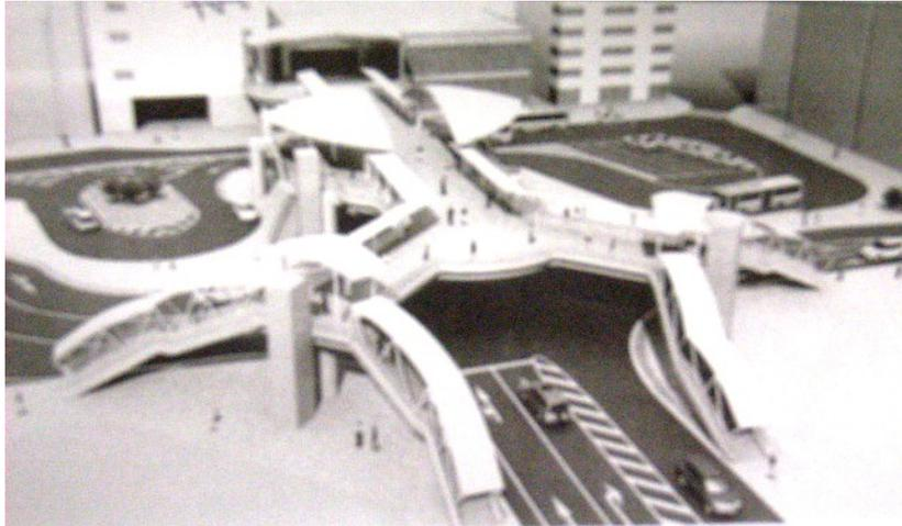
左図はイメージ図です。これは、西側からのイメージ図で、上部が川越駅、下部が国道16号の旭町1丁目交差点方面です。2Fデッキと1Fの歩道は、階段とエレベーター(4基)で行き来できるようになる予定です。図の右側は、バス・タクシーなどの公共交通車両用、左側が一般車両用と、ロータリーを分けて利用することで、安全を確保する計画です。(部分的に変更が生じる可能性があります。)
